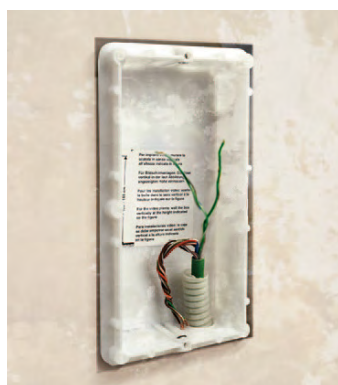
Utilisation d'une paire de fils existants pour connecter la nouvelle platine de rue
