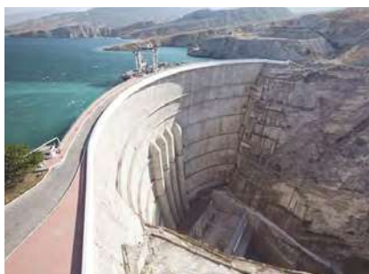
Impianti energetici Energy plants
